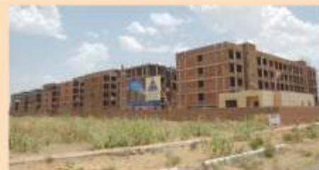
Actual Pictures of Construction Site
